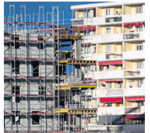
La construction avance mais ne va pas assez vite pour offrir assez de logements. Guinnard
